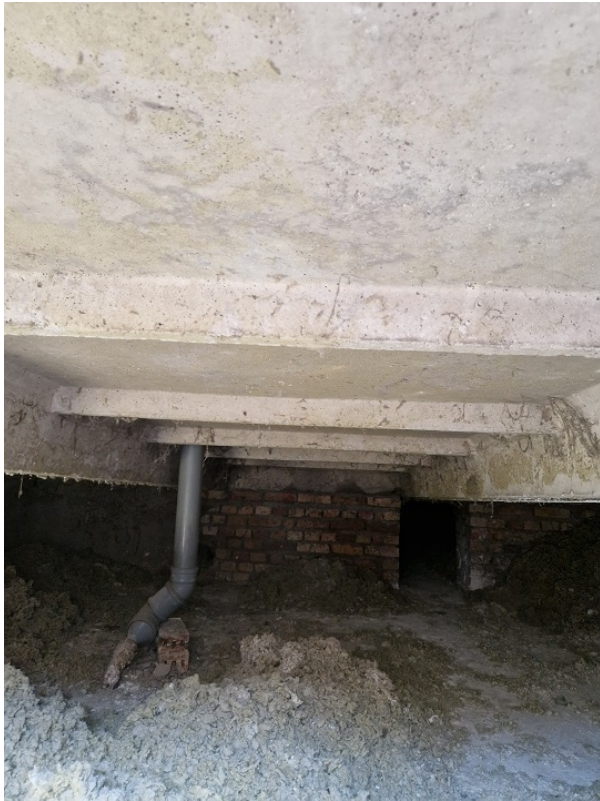
Fot. nr 7. Stropodach – płyty korytkowe na ścianach murowanych.
