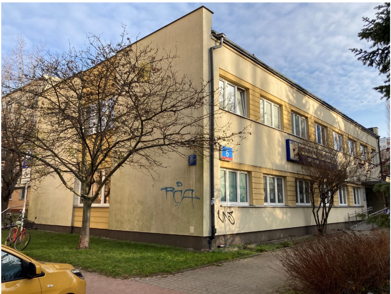
Zdjęcie nr 2. Widok budynku przychodni rejonowej przy ul.Sanockiej 6 w Warszawie.
