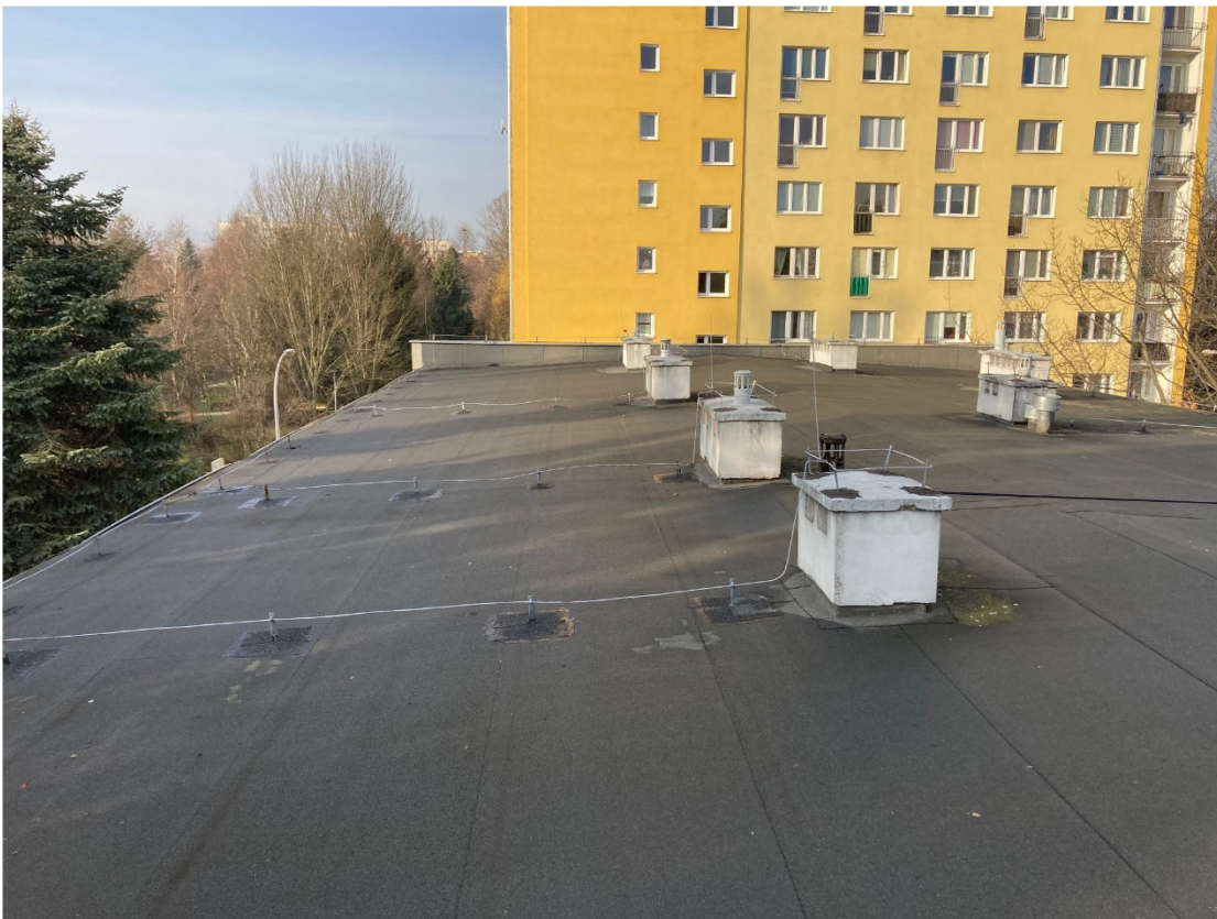
Zdjęcie nr 6. Zdjęcie połączeń dachowej przewidzianej do montażu paneli fotowoltaicznych
