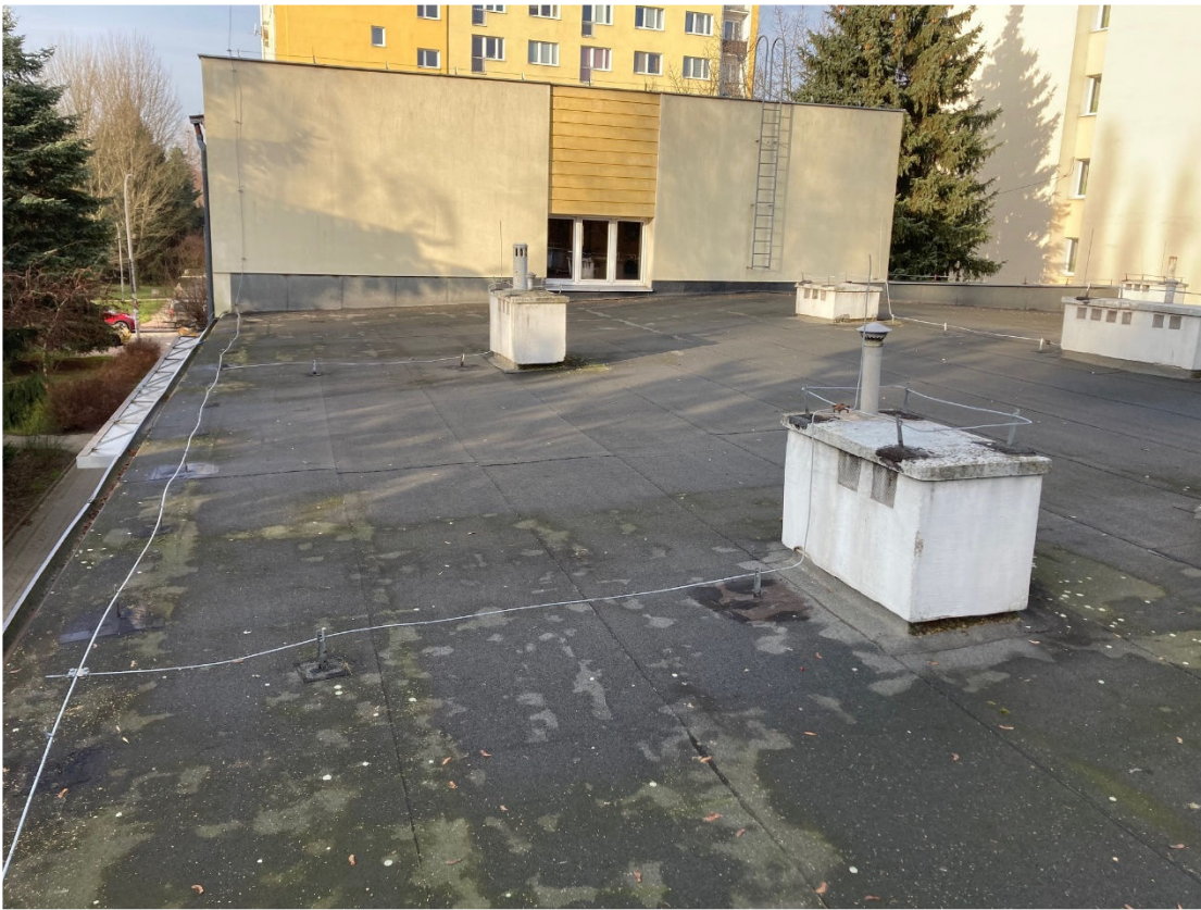
Zdjęcie nr 5. Zdjęcie połączeń dachowej przewidzianej do montażu paneli fotowoltaicznych
