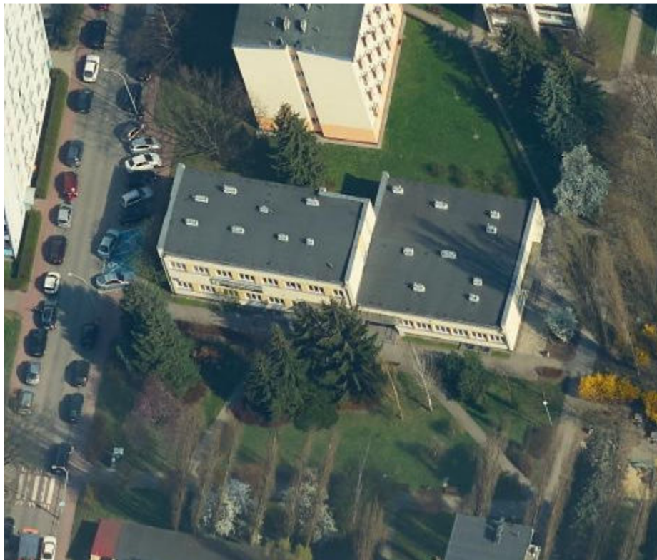
Zdjęcie nr 1. Widok budynku przychodni rejonowej przy ul.Sanockiej 6 w Warszawie
