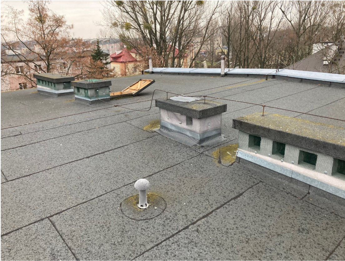
Zdjęcie nr 9. Zdjęcie połączeń dachowej przewidzianej do montażu paneli fotowoltaicznych
