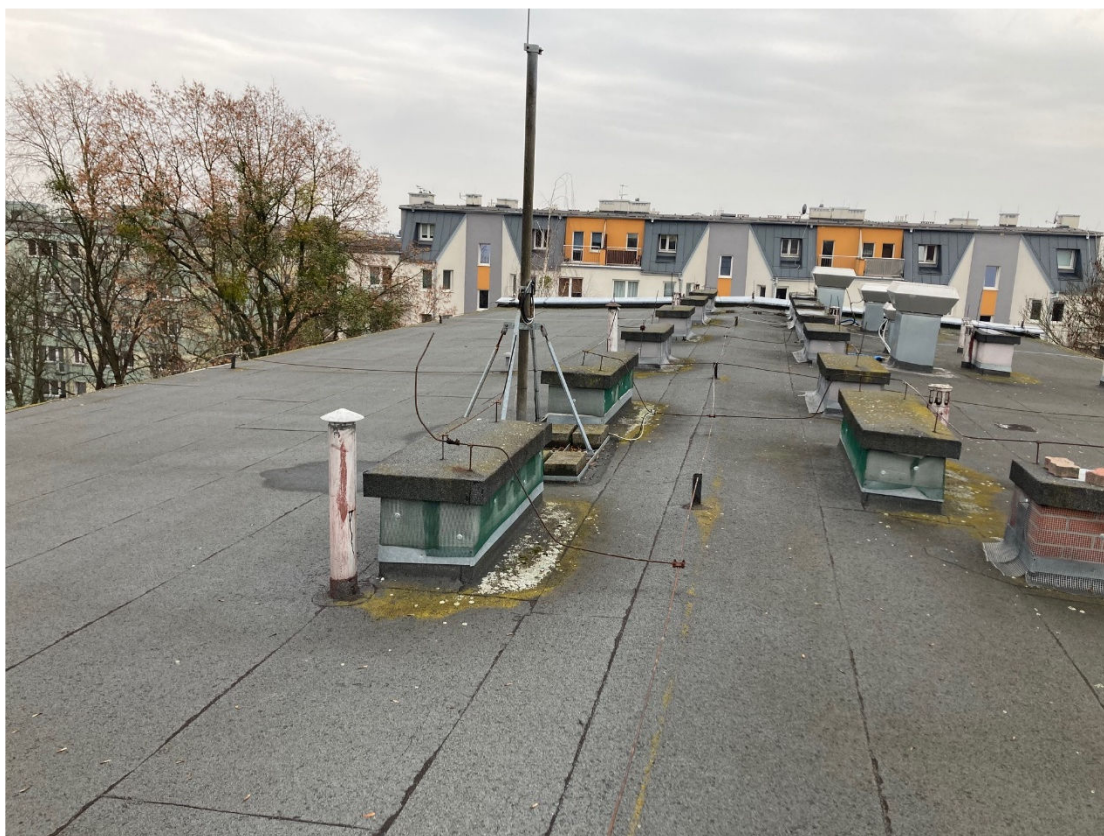
Zdjęcie nr 3. Zdjęcie połaci dachowej przewidzianej do montażu paneli fotowoltaicznych
