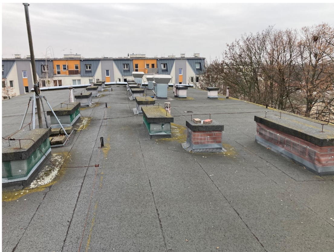
Zdjęcie nr 4. Zdjęcie połaci dachowej przewidzianej do montażu paneli fotowoltaicznych
