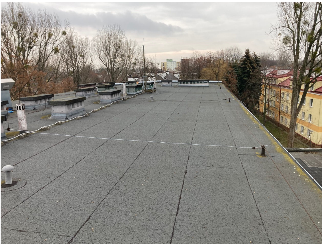
Zdjęcie nr 6. Zdjęcie połaci dachowej przewidzianej do montażu paneli fotowoltaicznych
