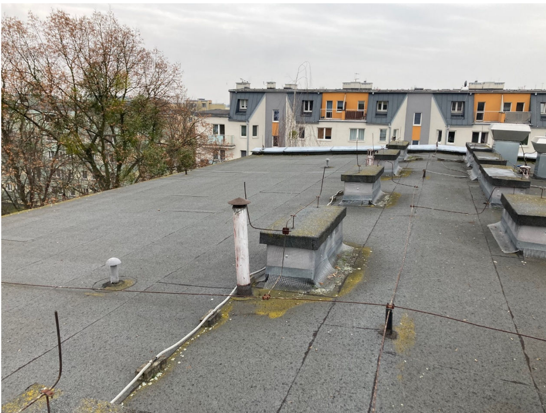
Zdjęcie nr 5. Zdjęcie połaci dachowej przewidzianej do montażu paneli fotowoltaicznych
