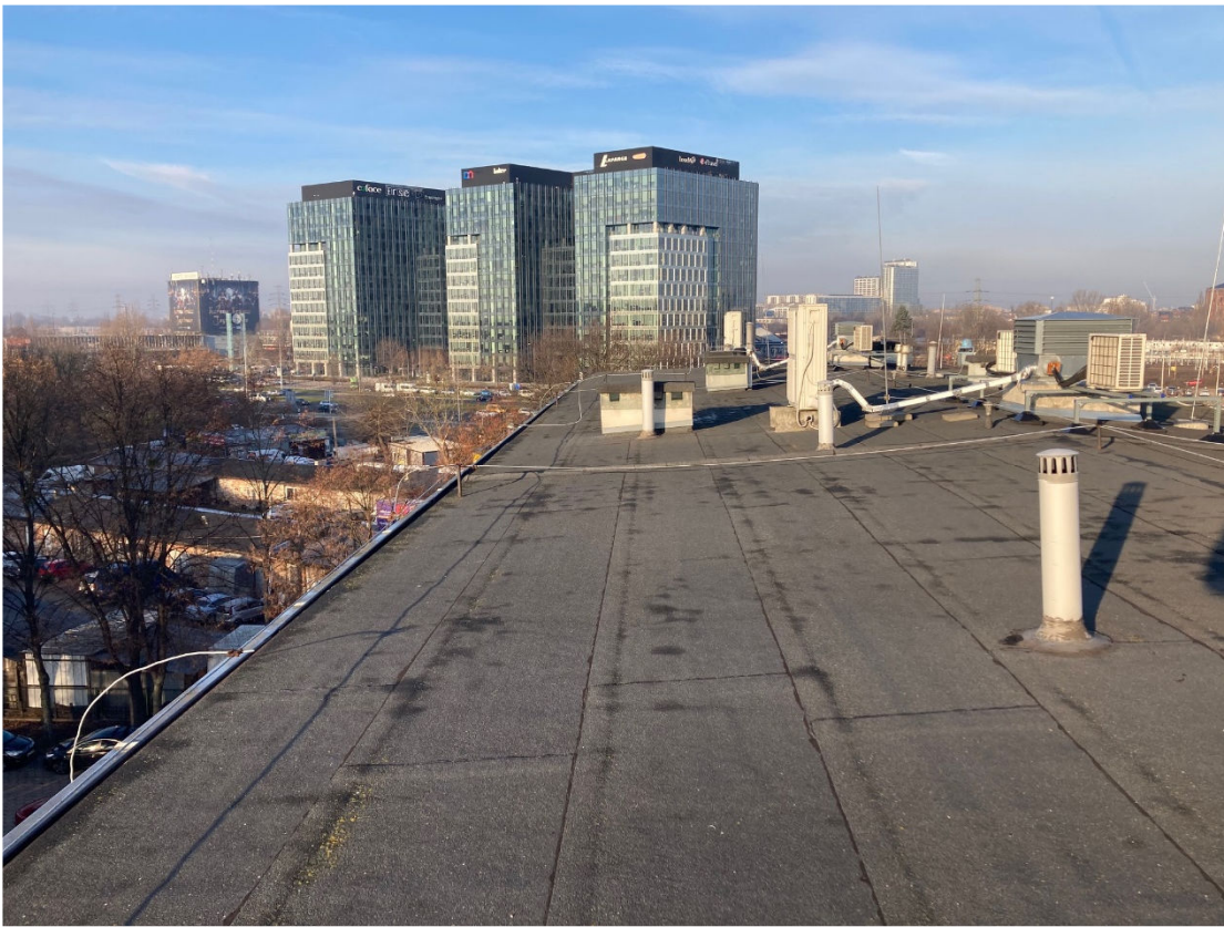
Zdjęcie nr 9. Zdjęcie połaci dachowej przewidzianej do montażu paneli fotowoltaicznych
