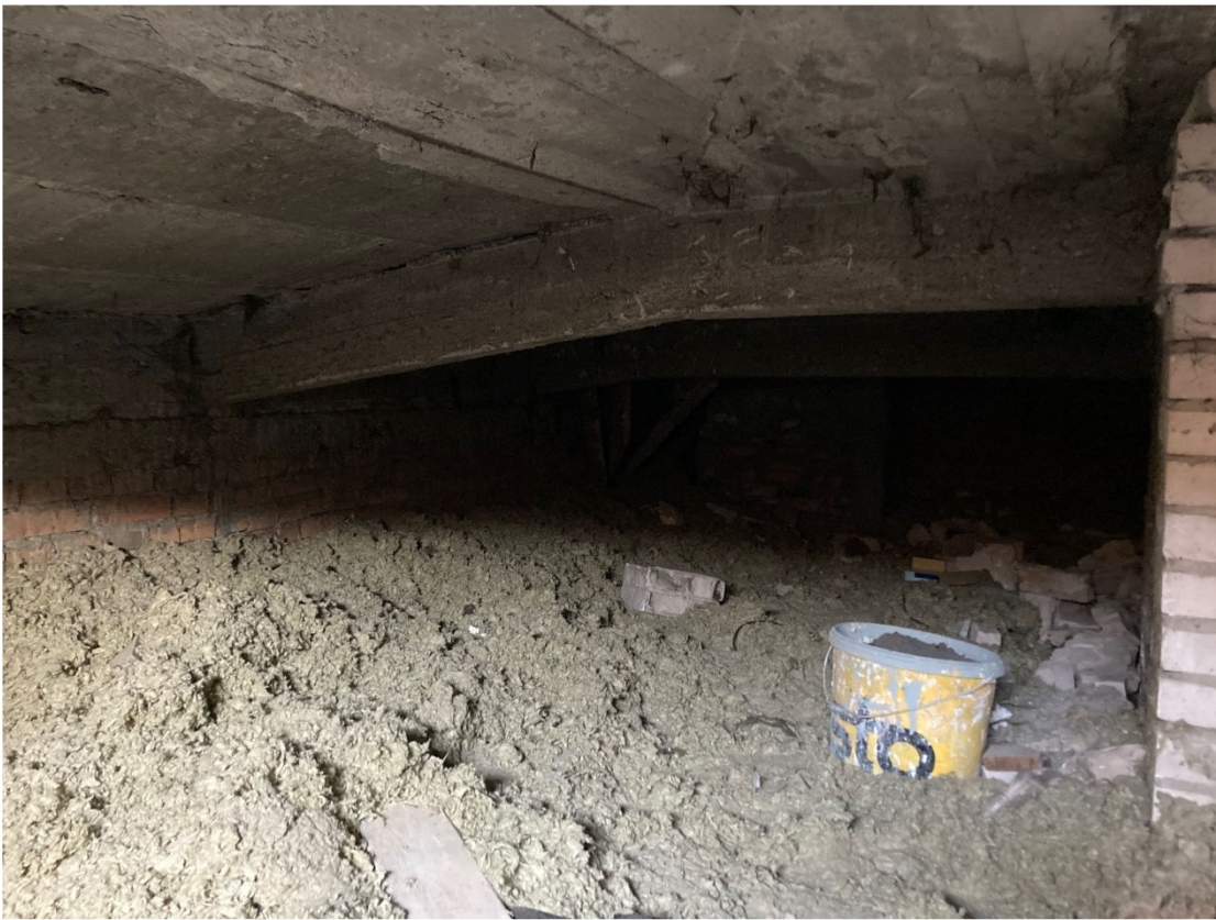
Zdjęcie nr 3. Zdjęcie stropodachu o konstrukcji żelbetowej.
