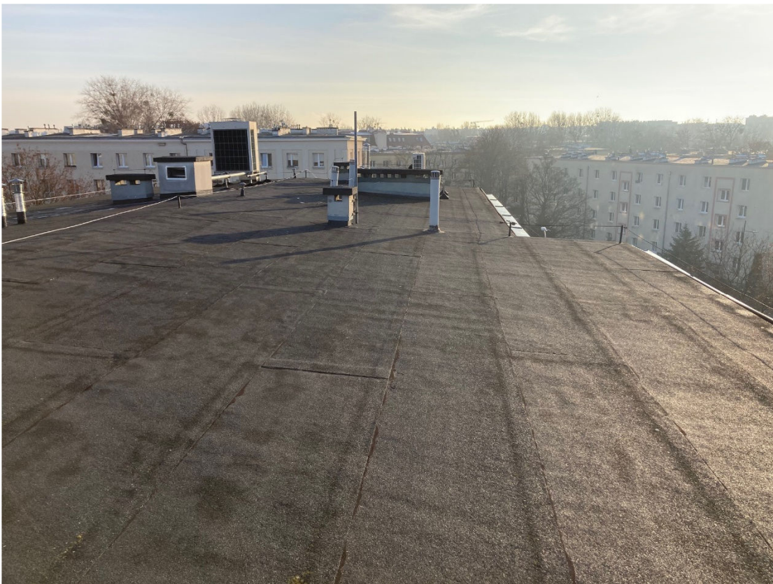
Zdjęcie nr 10. Zdjęcie połaci dachowej przewidzianej do montażu paneli fotowoltaicznych
