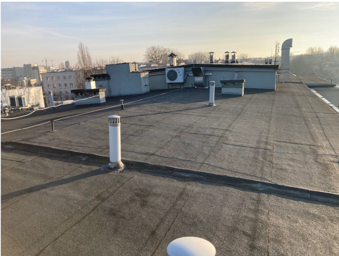
Zdjęcie nr 8. Zdjęcie połaci dachowej przewidzianej do montażu paneli fotowoltaicznych
