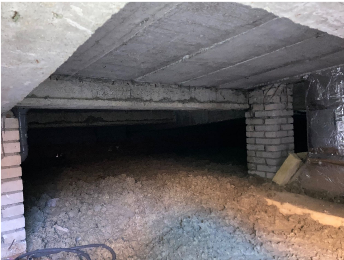
Zdjęcie nr 4. Zdjęcie stropodachu o konstrukcji żelbetowej
