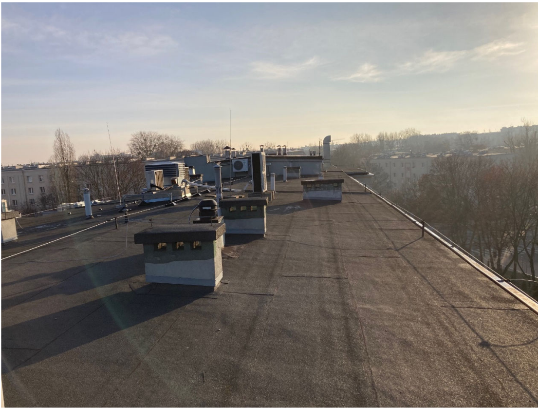
Zdjęcie nr 7. Zdjęcie połaci dachowej przewidzianej do montażu paneli fotowoltaicznych
