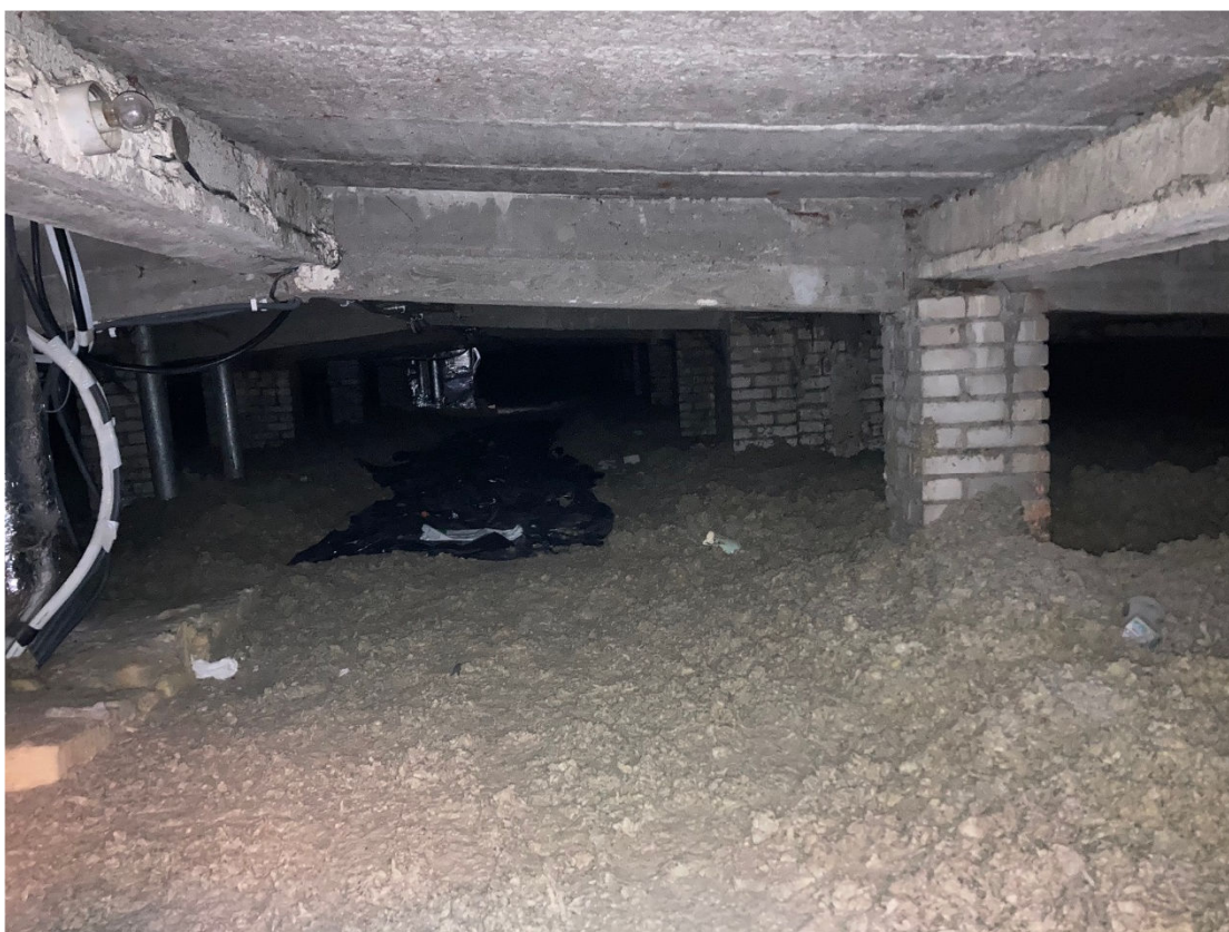
Zdjęcie nr 6. Zdjęcie stropodachu o konstrukcji żelbetowej
