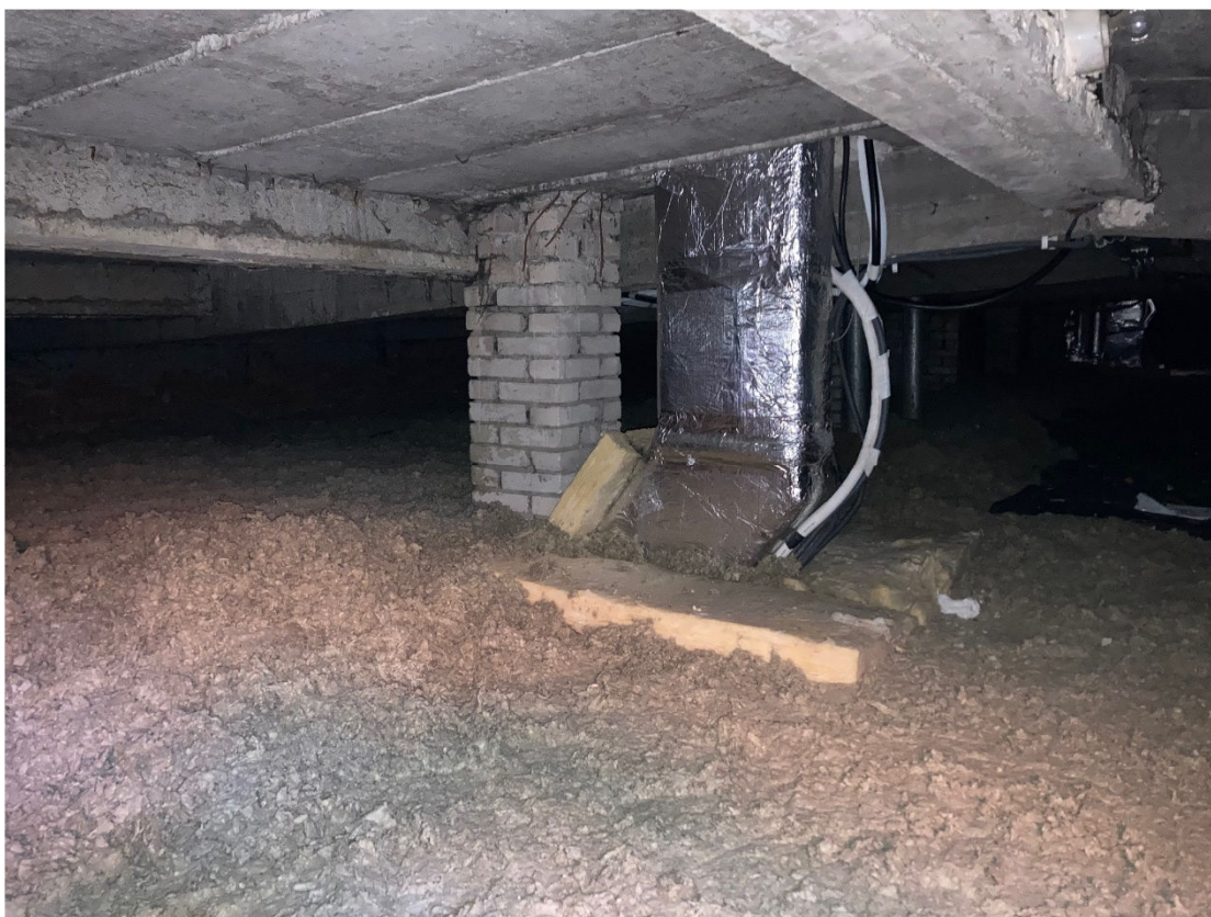
Zdjęcie nr 5. Zdjęcie stropodachu o konstrukcji żelbetowej
